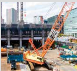
建築・工事現場
